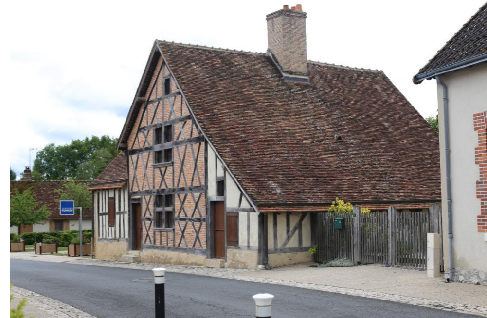
Photo 46 : La maison à pans de bois dite La Forge s'insère dans la trame bâtie du bourg de Veilleins
